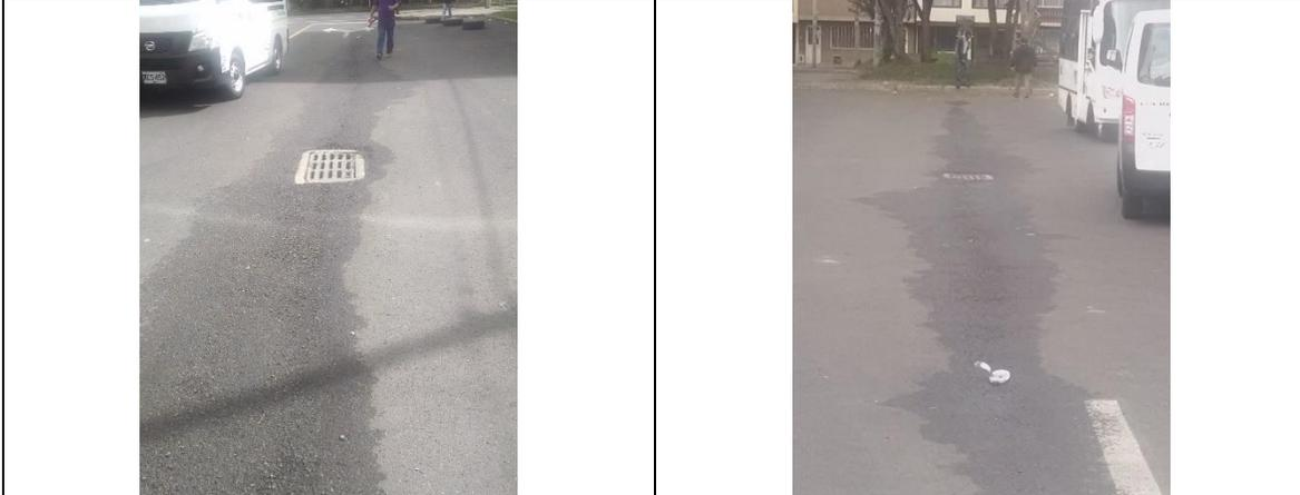
Vista sobre la calle 159 se observa el eje de la vía con humedad y desgaste de la carpeta. Vista sobre la calle 158 se observa el eje de la vía con humedad y desgaste de la carpeta.
