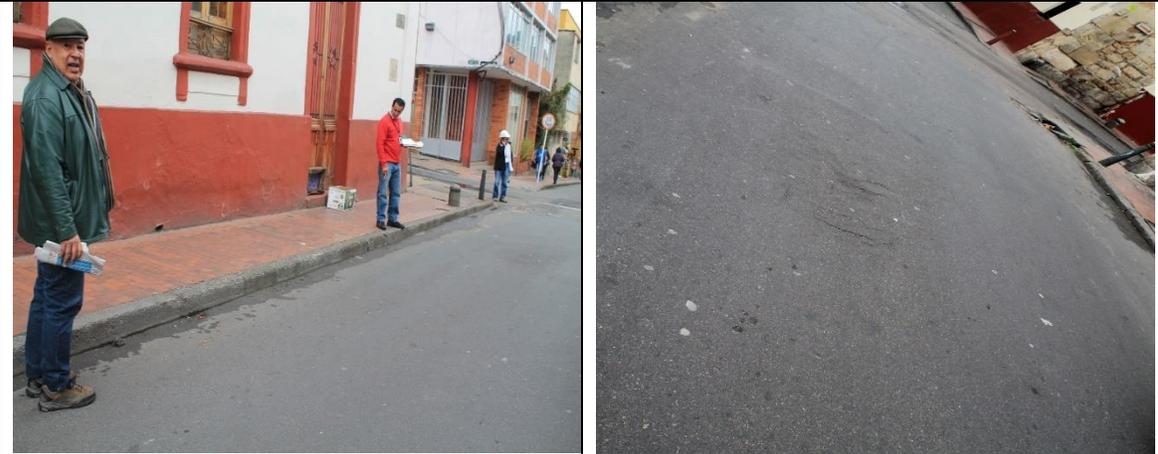
**CIV 17000216 – Desgaste lateral costado sur - Fisuras transversales placa 2-97**
