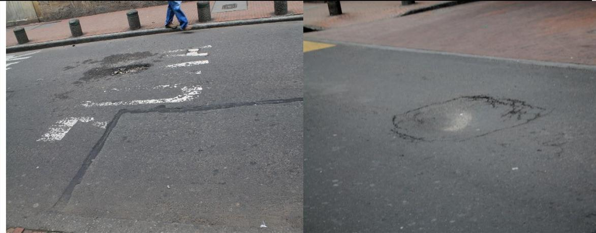
**CIV 17000162 - Hundimiento Placa 11-51 y Desgaste prematuro placa 11-67**
